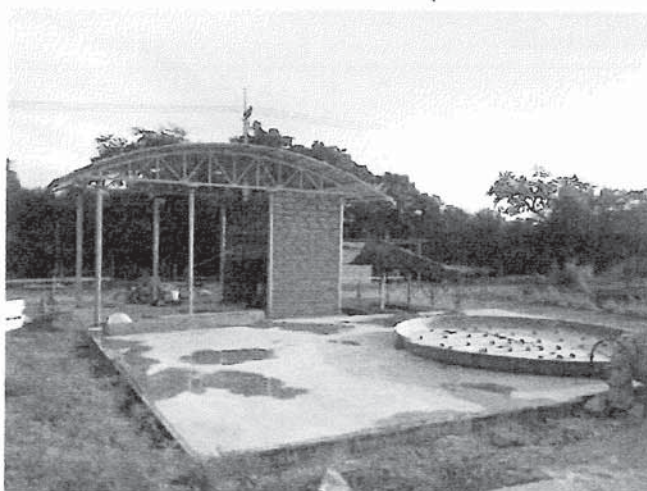
งานอาคารควบคุมและแท่นคอนกรีตเพื่อติดตั้งระบบบำบัดน้ำเสีย
