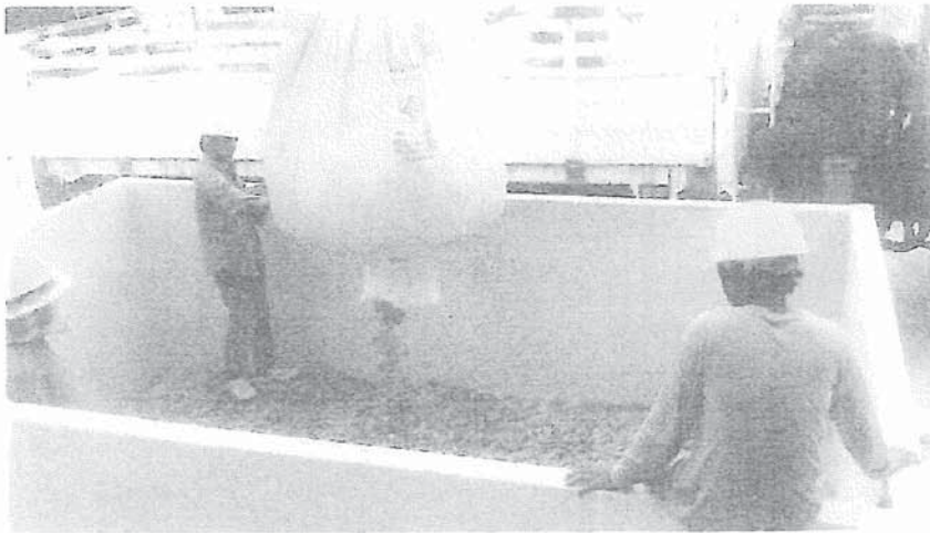
งานเติมกรวดบ่อตากตะกอน
